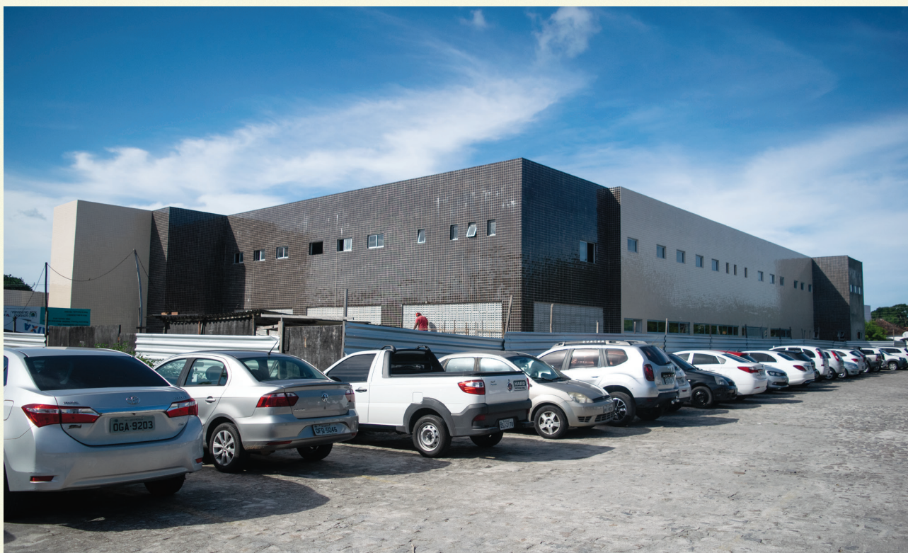
Nova ala de quimioterapia em fase final de construção
